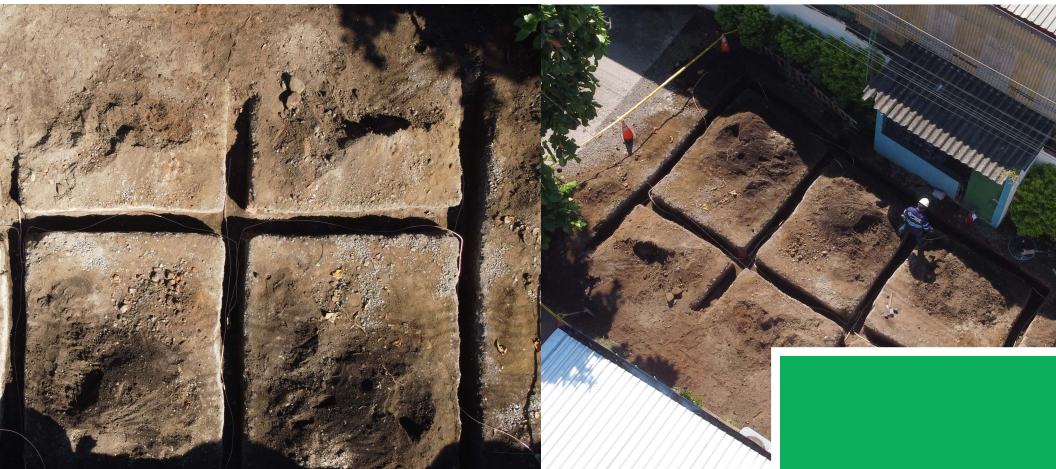
*Construcción red de tierra
